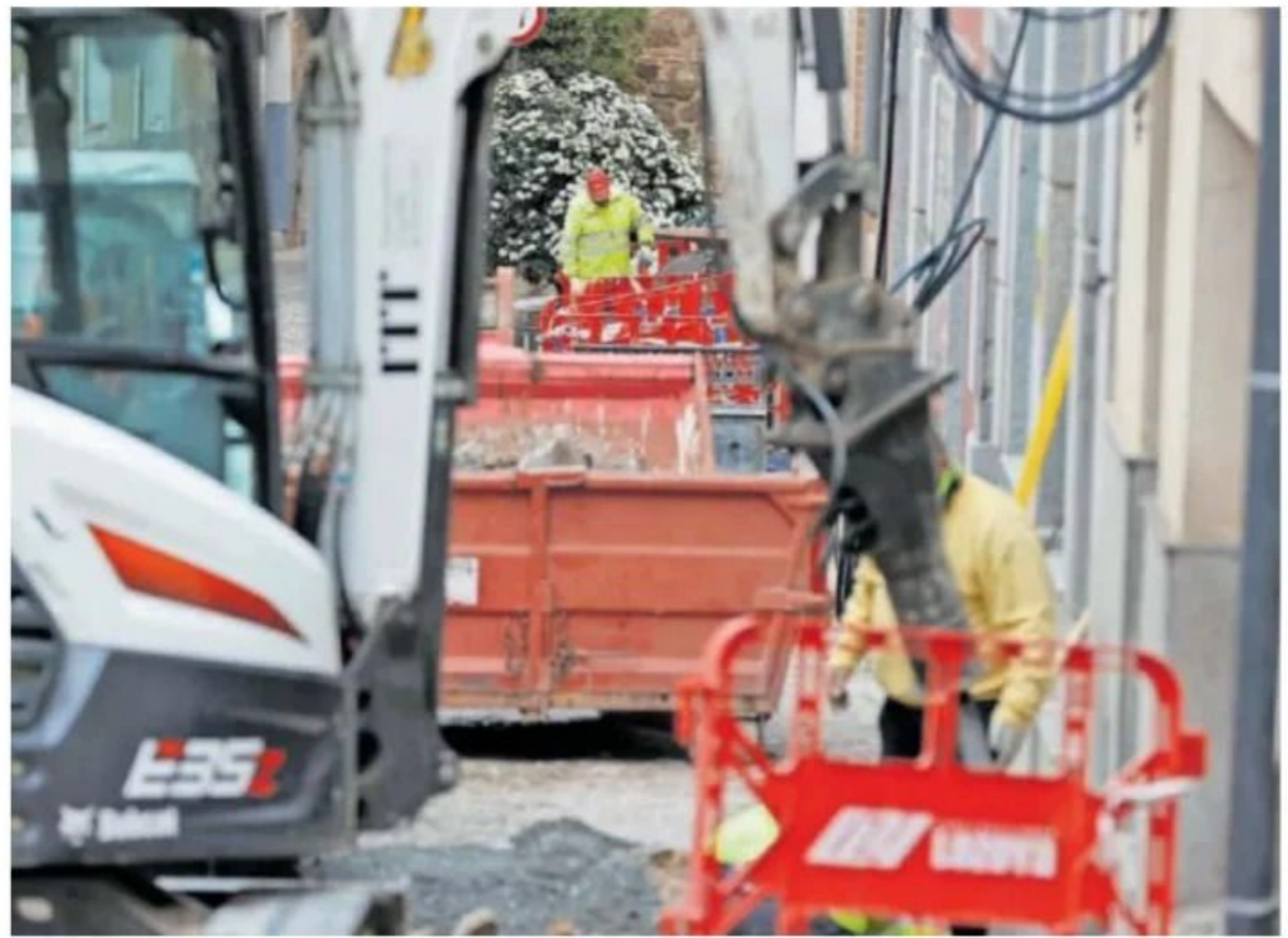
Dos operarios trabajaban el día 4 en una obra en Toledo. ISMAEL HERRERO (EFE)
